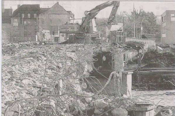
Alte Brücke über die Flutrinne Meeraner Straße ist abgebrochen
