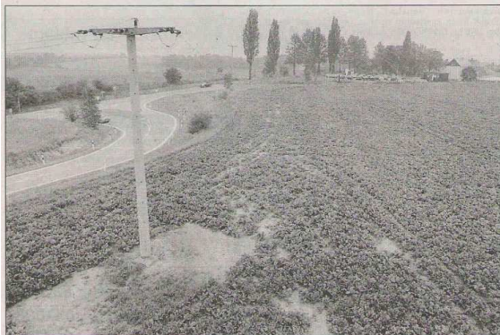
Diese Fläche am Rande der Großen Kreisstadt Glauchau, mit dem Namen „Güterverkehrszentrum-Modul Höckendorf“, wird sich demnächst in eine große Baustelle verwandeln. Vorgesehen ist, einen Autokhof nebst Tankstelle sowie Dienstleistungs- und Serviceeinrichtungen für Fahrpersonal und Kraftfahrzeuge zu errichten. Foto: Edgar Müller
