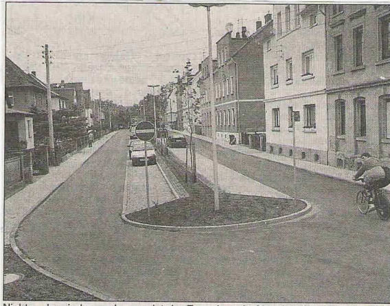
Nicht mehr wiederzuerkennen ist der Tunnelweg in Glauchau-Gesau nach seiner umfassenden Instandsetzung. Foto: Müller
